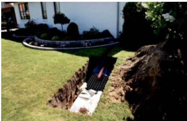
Faskine inden tildækning med jord - Foto fra Exponet
